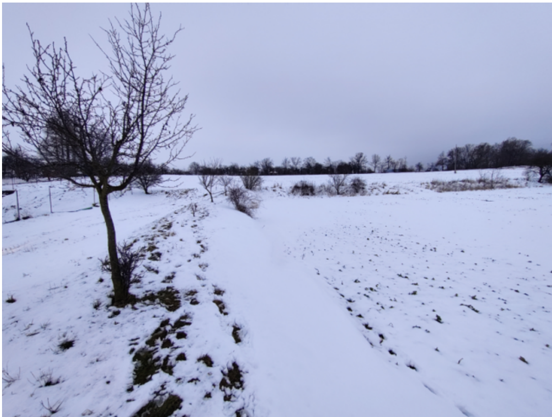
Obr. 7: Ochranná hráz nad lokalitou "Záškolí"
