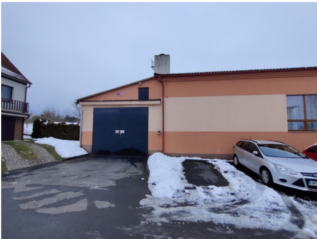
Obr. 2: Hasičská zbrojnice Dětkovice
